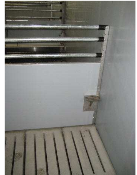
Auftritt zum Übersteigen der Buchtentrennwände
